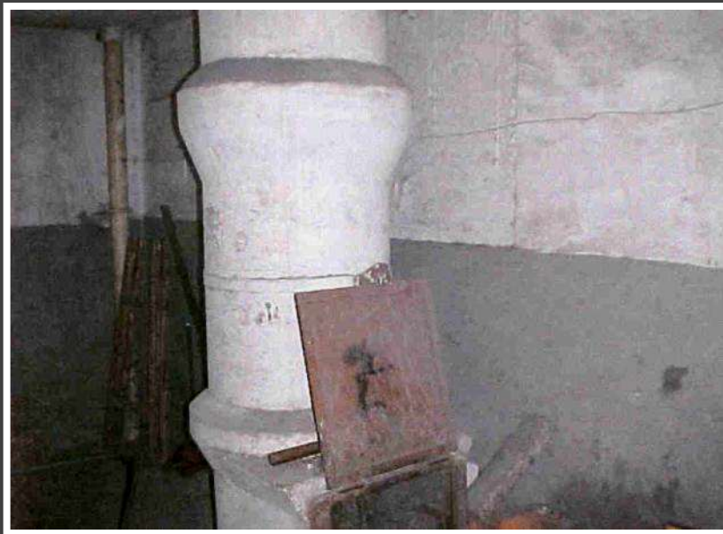
Refuse Chute 大廈垃圾槽
