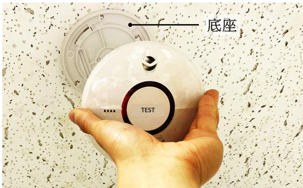
圖二 - 固定於底座的獨立火警偵測器
