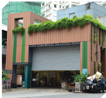
現有位於市區的垃圾收集站
